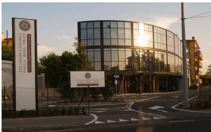
Foto – Vista da via Emilia Ovest. Facciate continue con elementi strutturali in vista. Portico con colonne ad arco tripartite ad albero.
