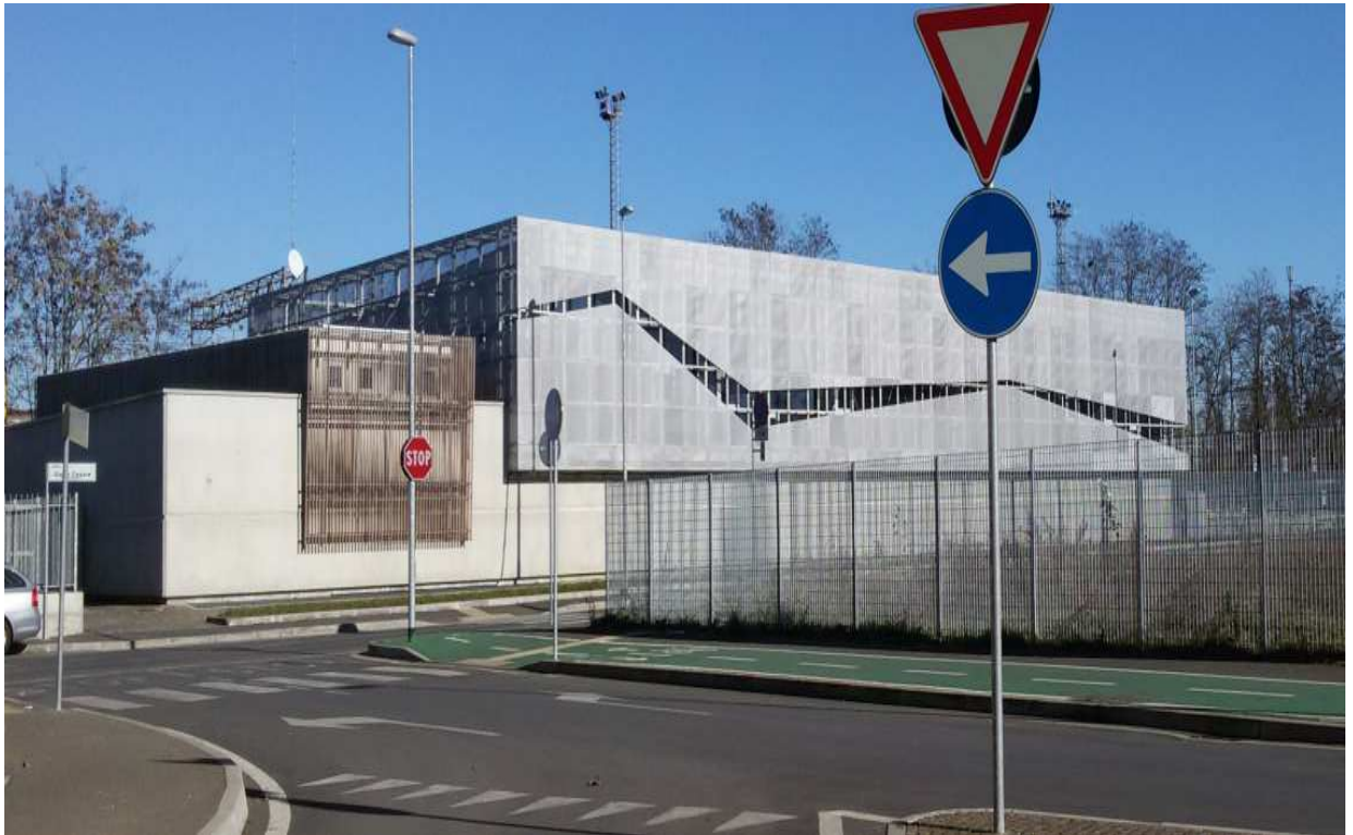
Foto – Vista edificio piscina coperta
