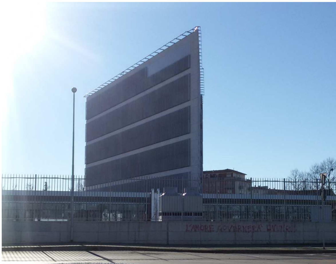
Foto – Vista da via Giulio Cesare - Edificio a torre sede “EFSA”
