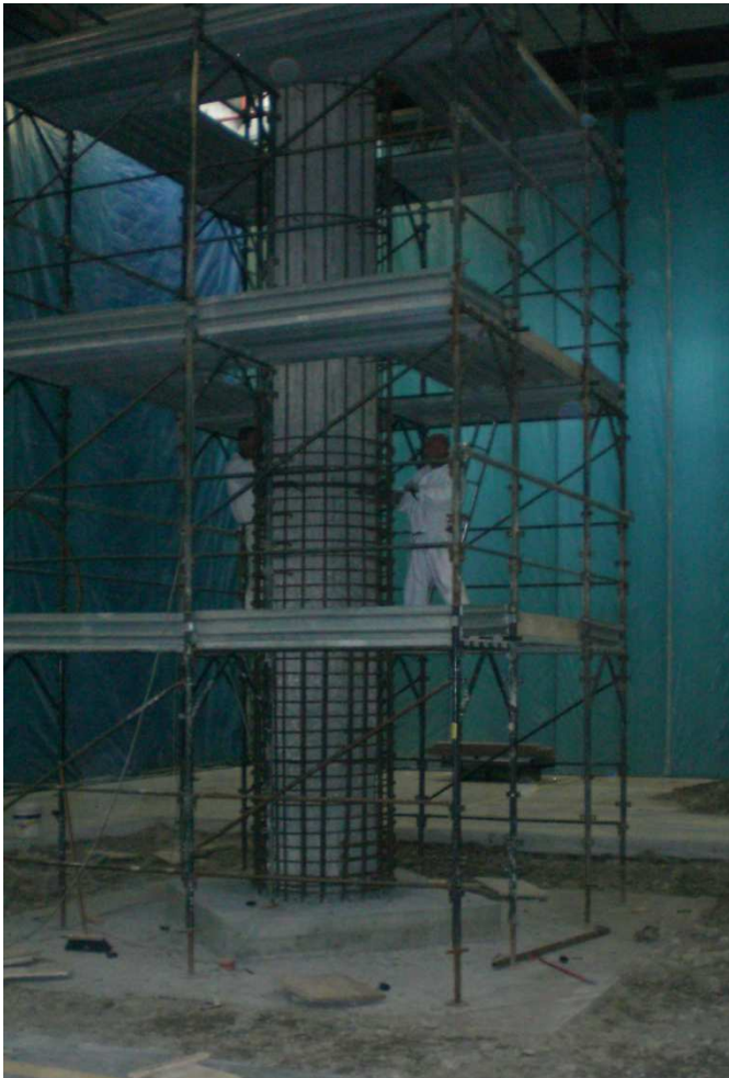
Foto – Intervento di consolidamento colonna tipo – in corso d'opera
